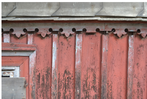
Obr. 5.: Bublava č. p. 129 – detail vyřezávané patrové římsy s ornamentem trojlístků. [Zdroj: Dominika Výšková (fotograf), 2024].
