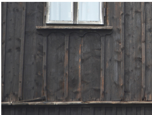
Obr. 3.: Bublava č. p. 389 – detail vyřezávaného podparapetního prkna. [Zdroj: Dominika Výšková (fotograf), 2024].
