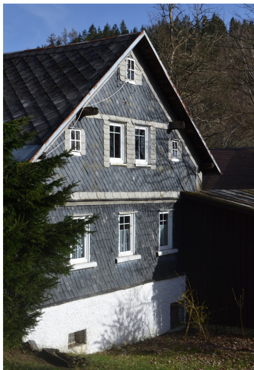
Obr. 12.: Bublava dům č. p. 34 – vzácný příklad fasády z břidlicových šablon. [Zdroj: Dominika Výšková (fotograf), 2024].
