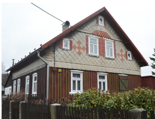
Obr. 6.: Bublava č. ev. 142 – výtvarně hodnotné obložení eternitovými šablonami. [Zdroj: Dominika Výšková (fotograf), 2024].
