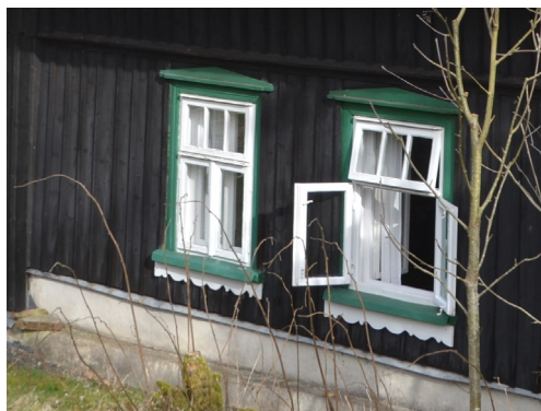
Obr. 13.: Bublava č. ev. 89 – detail dochovaného původního špaletového okna. [Zdroj: Dominika Výšková (fotograf), 2024].
