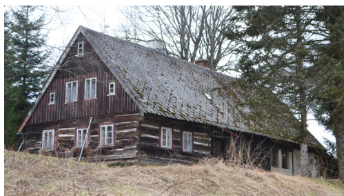
Obr. 11.: Bublava dům č. ev. 71 – vzácný příklad dochované roubené konstrukce vystavené působení počasí v drsných klimatických podmínkách kraslického mikroregionu. [Zdroj: Dominika Výšková (fotograf), 2024].
