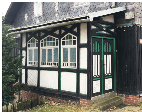
Obr. 8.: Bublava č. p. 475 – hrázdková konstrukce vstupního zádveří zvaného Schneehaus s oknem s malými barevnými skleněnými tabulkami. [Zdroj: Dominika Výšková (fotograf), 2024].
