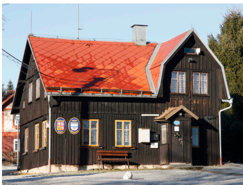
Obr. 2.: Bublava č. p. 389 se svislým prkeným bedněním s krycími lištami. [Zdroj: Dominika Výšková (fotograf), 2016].
