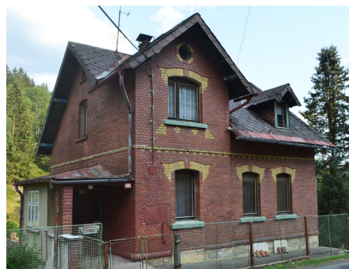
Obr. 9.: Bublava dům č. p. 481 – dvoubarevné režné zdivo se žlutými cihlami použitými v nadpraží oken, patrové římsy, pod parapetem okna a jako ostění kulatého okna ve vrcholu štítu. [Zdroj: Dominika Výšková (fotograf), 2023].
