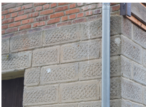
Obr. 7.: Bublava č. ev. 75 – suterénní zdivo z prefabrikovaných betonových kvádrů s bosáží. [Zdroj: Dominika Výšková (fotograf), 2024].
