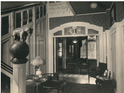
Obr. 3.: Pohled do interiéru vily z roku 1924, neznámý (Zdroj: stavebně historický průzkum, NPÚ Ostrava 2009)
